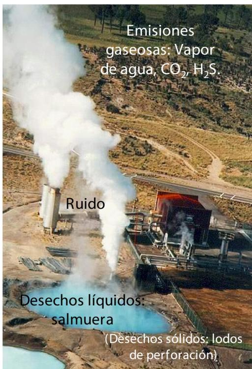
Fig. 4. Impactos ambientales causados por la geotermoelectricidad
